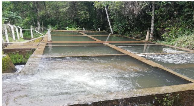
Figura 25. Desarenador del acueducto de los municipios de Agrado y Pital. Quebrada La Yaguilda
